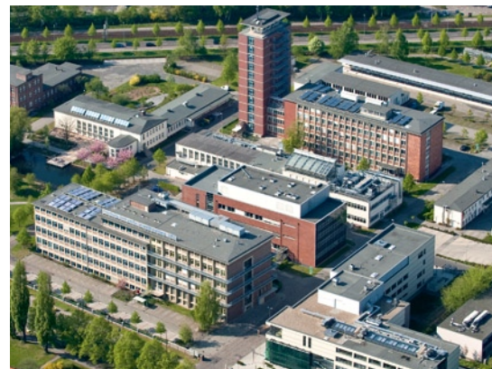
UFZ premises in Leipzig, Permoserstraße 15
