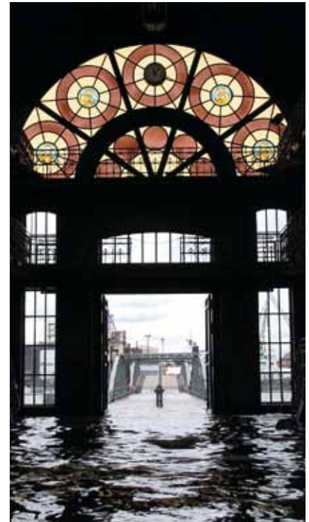
→ ABB. 38 Blick durch die überflutete Fischauktionshalle zur Elbe
