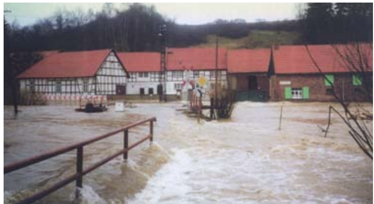
→ ABB. 17 Hochwasser an der Selke in der Ortslage am 13. 04. 1994
