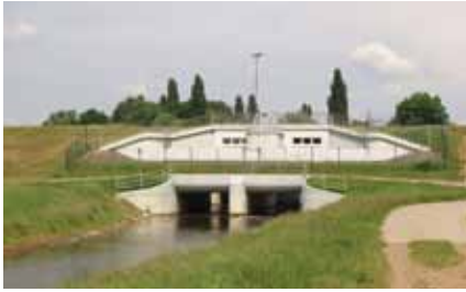
→ ABB. 26 Auslassbauwerk des Hochwasserrückhaltebeckens Horschheim an der Erft
