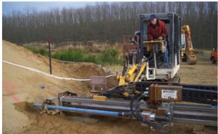
→ ABB. 32 Einbringen von Dränelementen aus geschlitzten PVC-Rohren in einen Deich
