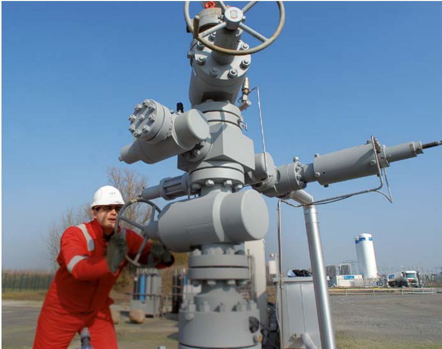
Arbeiten an der Einspeisungsanlage
