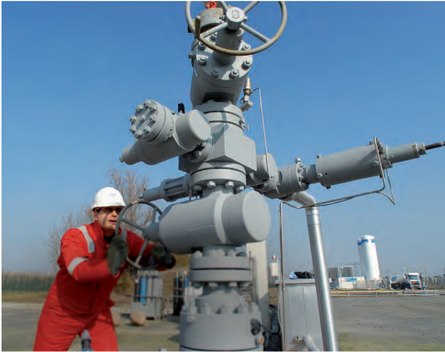
Arbeiten an der Einspeisungsanlage
